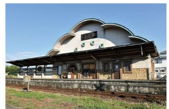
2020年7月豪雨から運行されていない「くま川鉄道」の多良木駅はブルートレイン多良木のすぐ近く。
